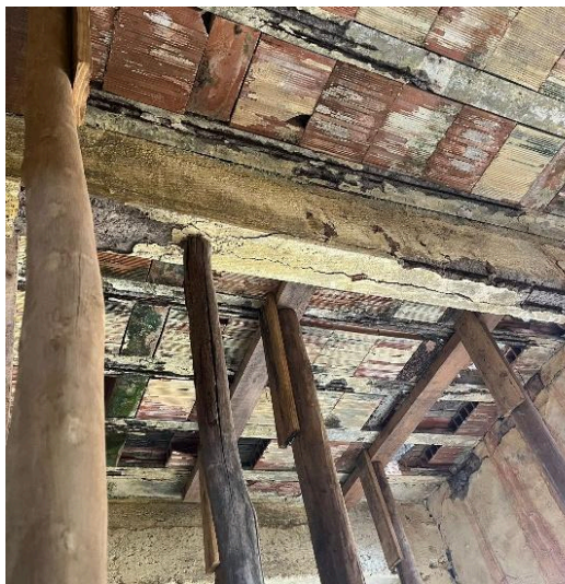
Escoramento para execução de reforço estrutural.
