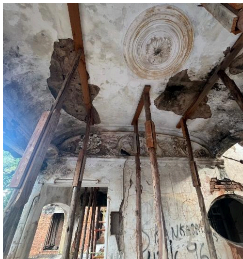
Escoramento para execução de reforço estrutural. Autoria: Eduardo Santos Data: 10/06/2025
